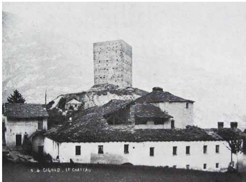
Gignod. Torre e casaforte di Archery
