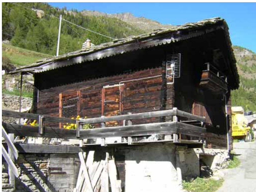
Perquis. Grenier nel centro storico del villaggio
