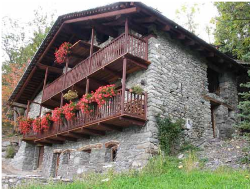
Esempio di recupero di un'edificio storico a La Cou
